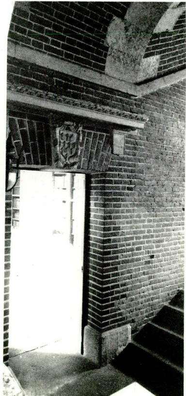
Détail de la cage d'escalier.
